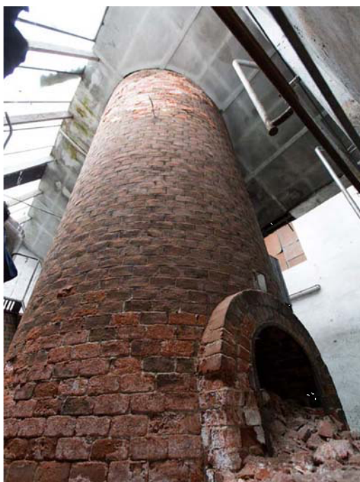
VISTA INTERNA AREA FORNACE
