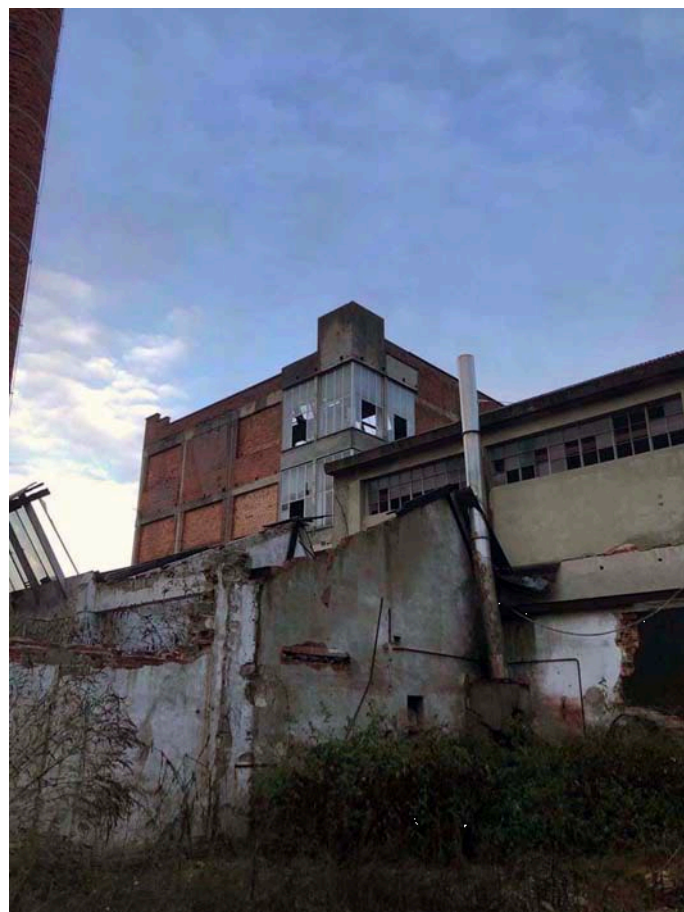
FOTO CORPO ALTO DA EST
