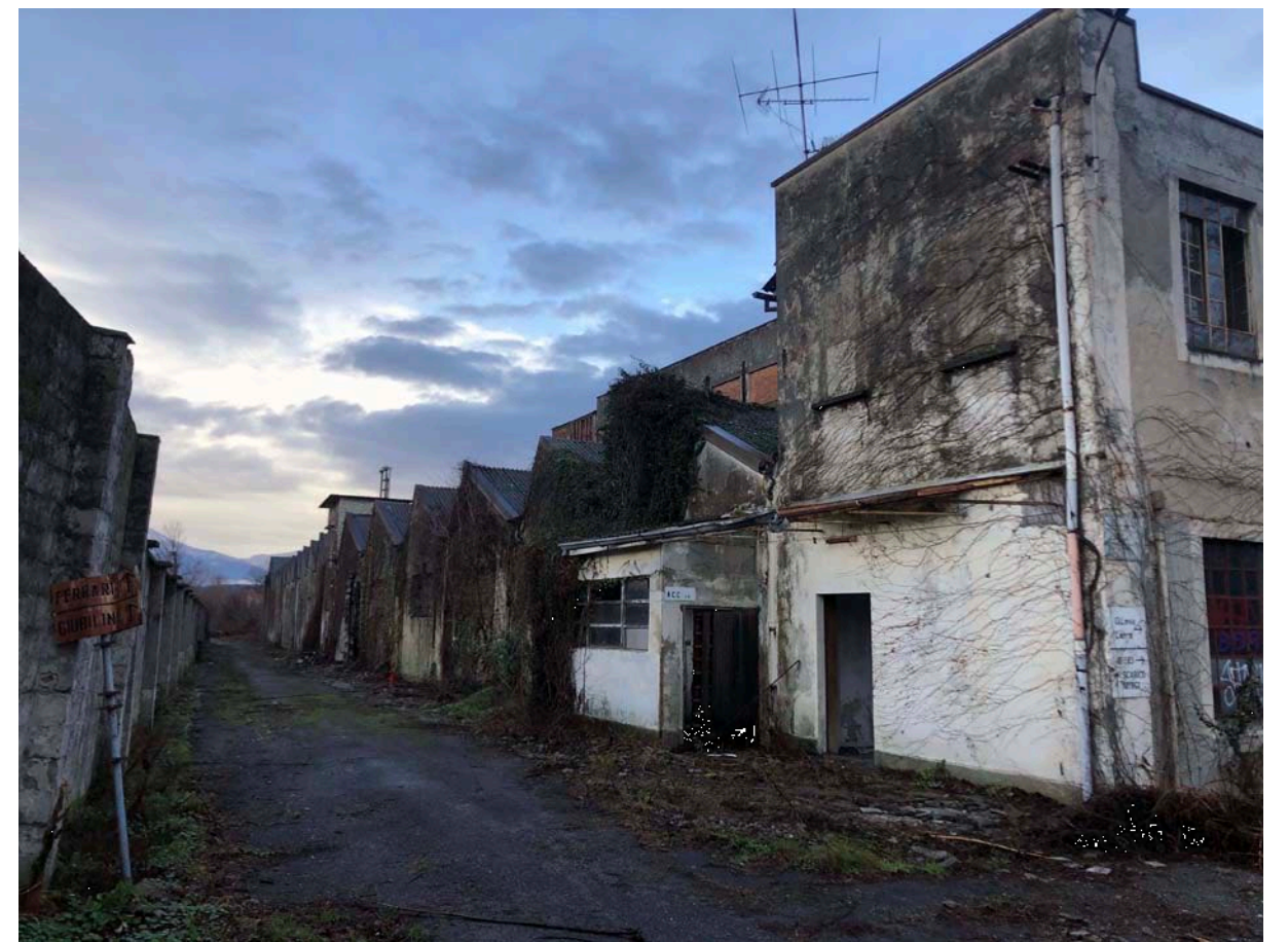
FOTO EDIFICIO PRINCIPALE DA EST
